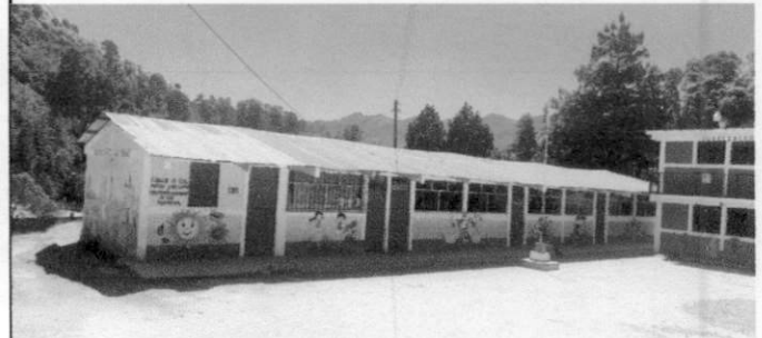
Foto 2: Canales y bajadas de agua pluvial
