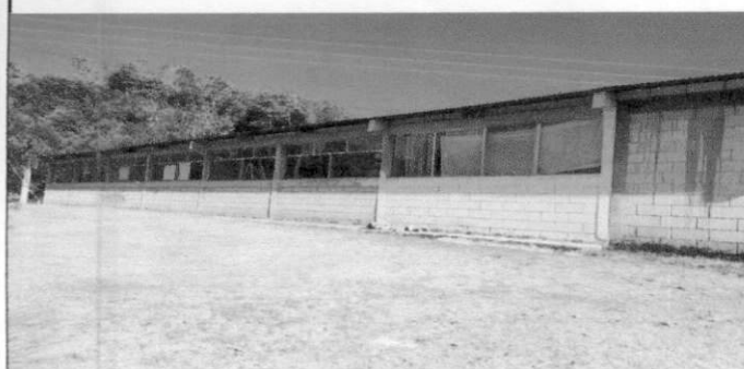
Foto 3: Repello en muro para evitar la humedad
