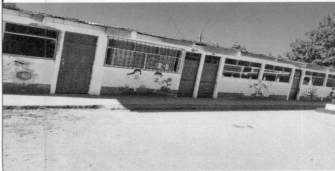
Foto1: Pintura de interior y exterior del edificio escolar
